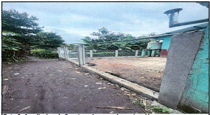
Foto 6: Ampliacion de 8 metros de muro de contención.
