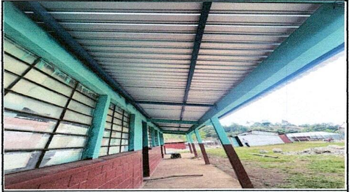
Foto2: Pintura de estructura portante de cubierta de lamina.
