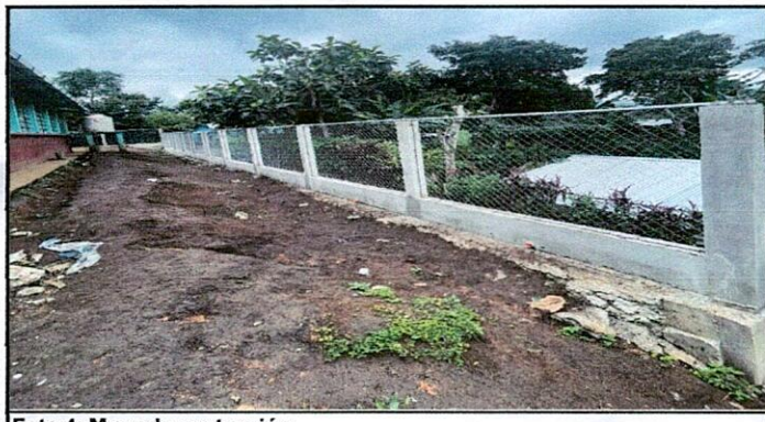
Foto 4: Muro de contención.
